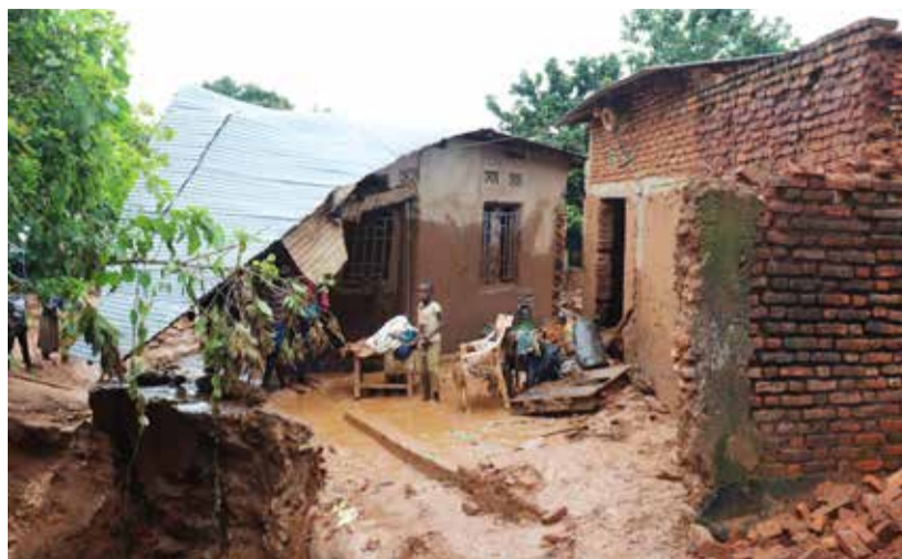
Les dégâts causés par les fortes pluies qui s'abattent actuellement sur tout le pays sont nombreux.
