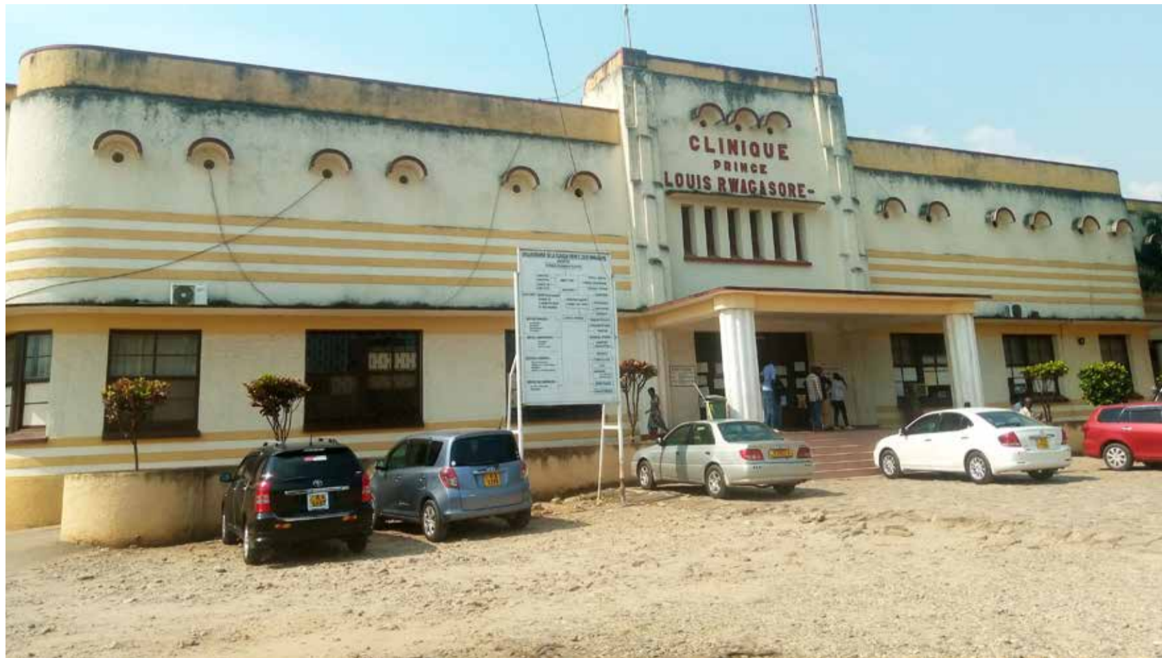
La Clinique Prince Louis Rwagasore aujourd'hui converti en hôpital ordinaire est menacé par le manque d'entretien.
