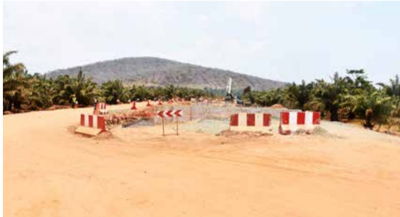
Les travaux de construction de la route Rumonge-Gitaza ont commencé alors que l'Agence Routière du Burundi (ARB) n'a pas été en mesure d'obtenir le consultant qui réalisera l'enquête de base.
