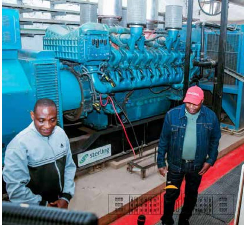
Evariste Ndayishimiye, Président de la République du Burundi demande de mener des investigations pour l'inexplicable choix de louer la centrale thermique appartenant à la société « Interpetrol ». (Photo : Ntare House)
