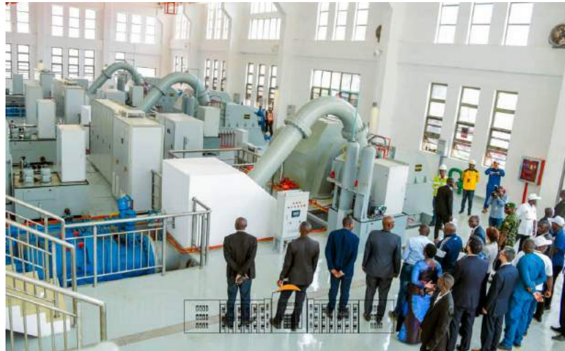
Inauguration de la centrale hydroélectrique d'une capacité de 15 MW construite sur financement de la Chine (Septembre 2022).
